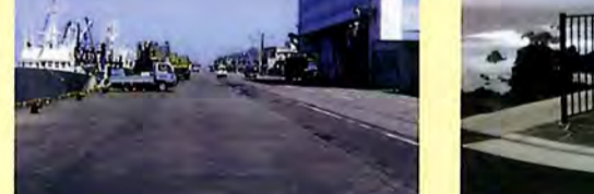
(離島の海岸沿いにH14年同時に布設し2年後に確認)
