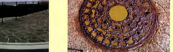
(左右の写真共 流域下水道路線区)
